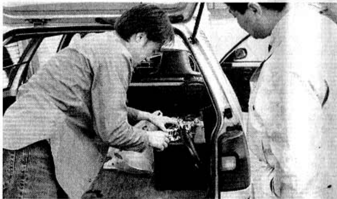
公用車への新しい発電キットの取り付け
